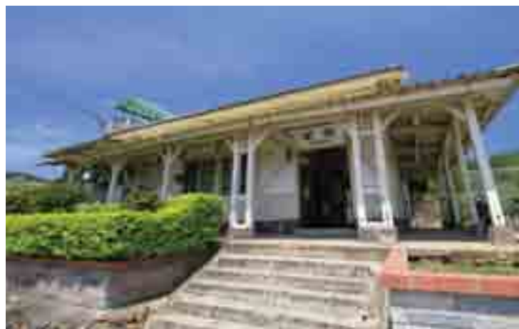
木造結構的新埔車站
