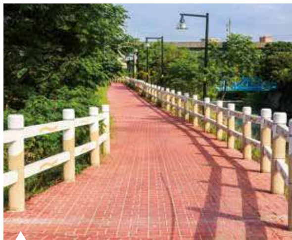
北勢溪自行車道路面鋪設完善
